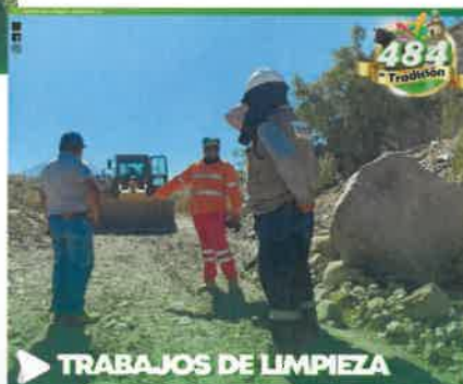
▶ TRABAJOS DE LIMPIEZA
